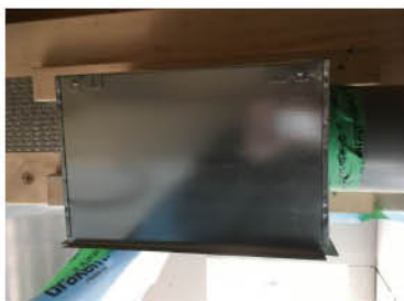
3. Dra in styrkabel, enklast genom att borra hål i boxen på lämpligt ställe. Fixera och täta kring monterörret och styrkabel.
