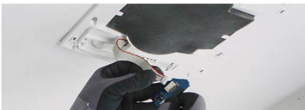
7. Koppla styrkort med kontakt.
