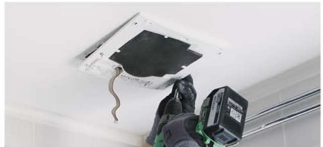
6. Träd styrkortskontakt genom fläktkåpa och skruva dit.
