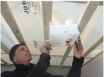
Hus går att fixera med bakåt eler "sidoutblås". Gör hål i klimatskal.
