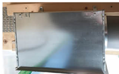
2. Fixera akustikbox i regel eller innertak. Säkerställ att monterörret inte lutar innåt.
