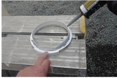
2. Fixeras med montage­lim
