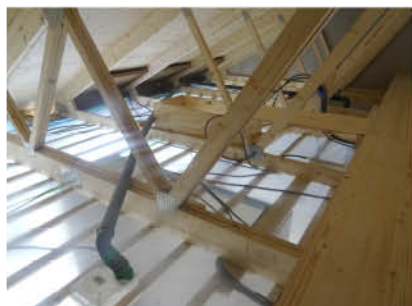
Ventilationsrör 80 mm allt 76 millimeter avloppsrör som kombineras med ventilationsslang.
